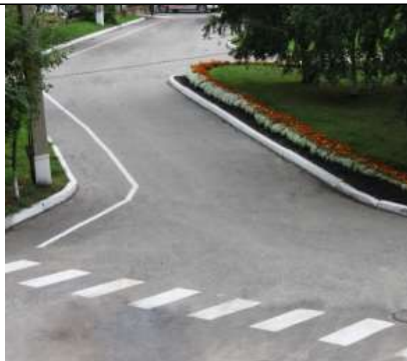
На проезжей части территории учреждения выделена пешеходная полоса
