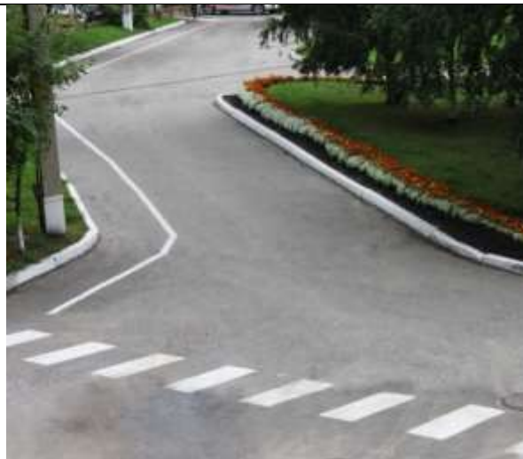
На проезжей части территории учреждения выделена пешеходная полоса
