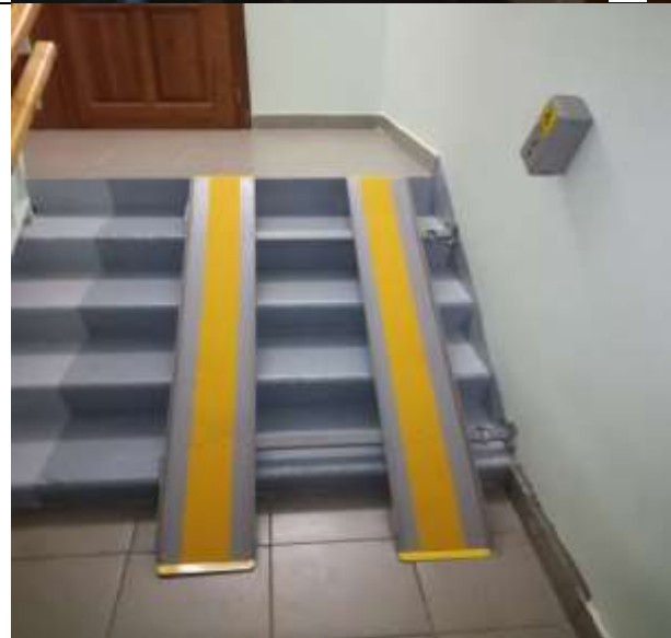
Запасные выходы №10, 11 оборудованы откидными аппаратами
