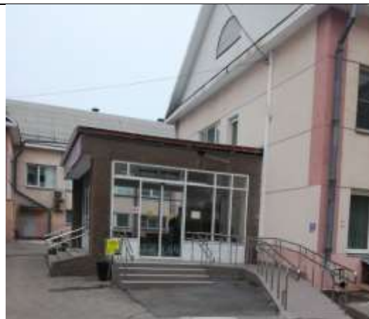
Пандус, кнопка вызова помощника, наружная распашная дверь
